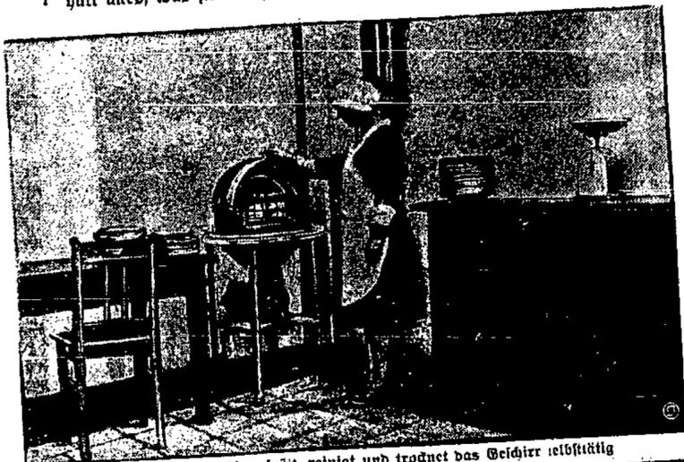
Geschirrwaschmaschine, spült, reinigt und trocknet das Geschir selbsttätig
