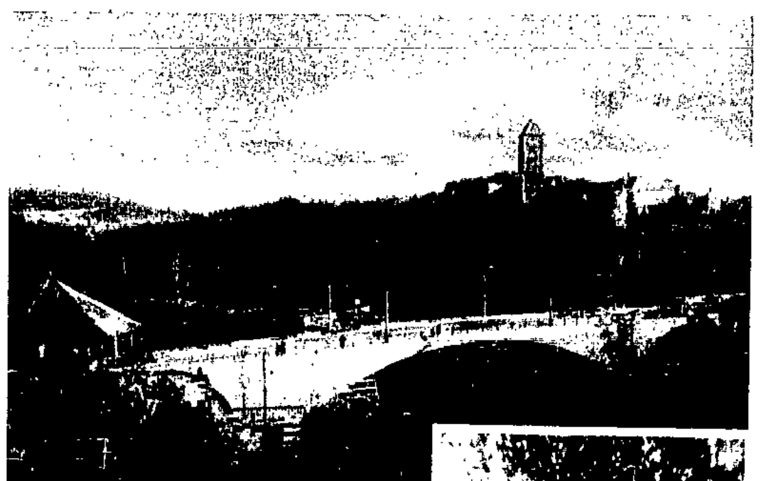
Die neue Saalebrücke bei Halle unterhalb der Burg Giebichenstein
