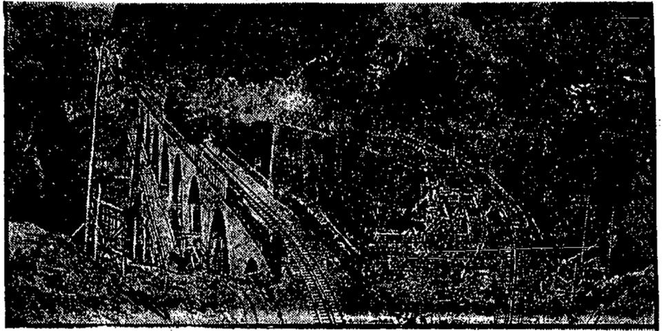
Auf unserem Bilde sieht man die beiden Brücken nebeneinander; rechts die alte Eisenbrücke, die noch in einer Kurve die Schlucht überbrückt, links die neue Brücke, die in gerader Linie gebaut ist. Die Eisenbahn überwindet zwischen den
