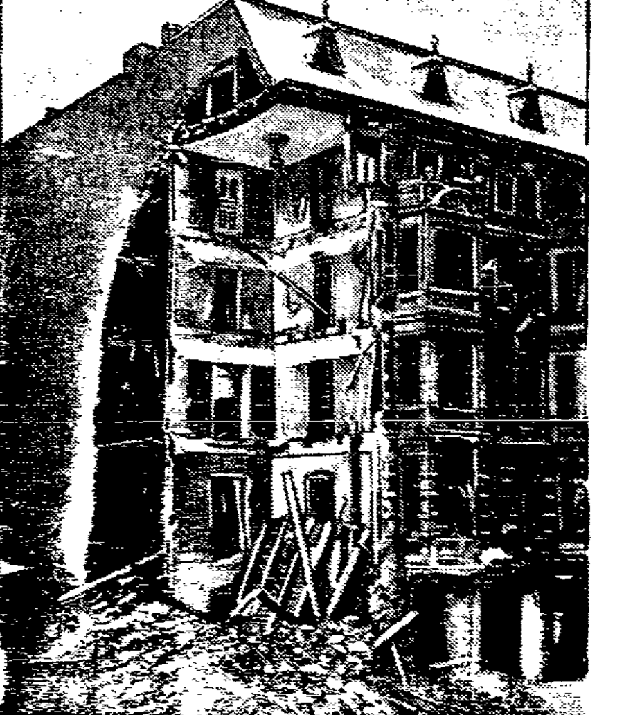
Das durch eine Explosion im alten Berlin Stadtteil Moabit teilweise zerstörte Haus Kirchstraße 2
