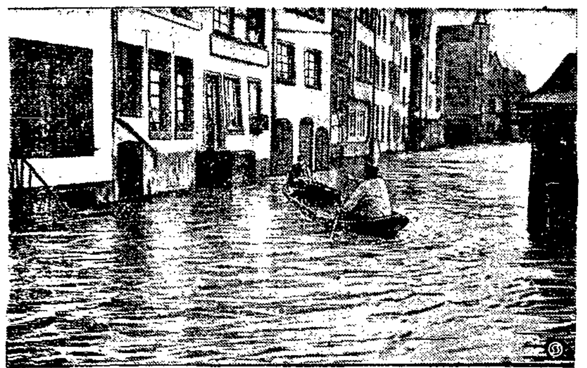
Eine vom Hochwasser überflutete Straße in Köln. Der Verkehr kann zum Teil nur mit Rähnen anrecht erhalten werden. (Obenstehendes Bild.)
