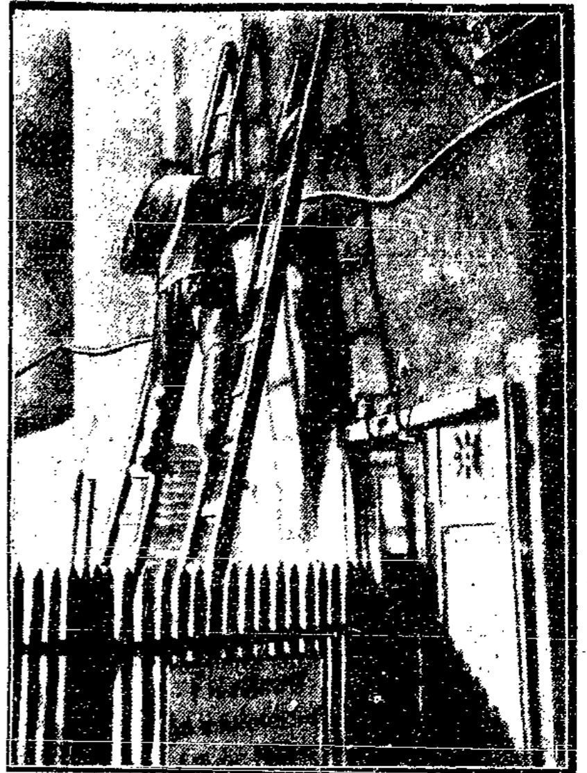
Auf unserem Bilde sieht man das durch eine Art zerstörte Kabel, das die Rede des Reichskanzlers von der Stadthalle in Stuttgart zum Telegraphenamts weiterleiten sollte. Befanlich wurde durch die Zerstörung des Kabels an dieser Stelle die Übertragung der Rede auf den Rundfunk für längere Zeit unterbrochen.
