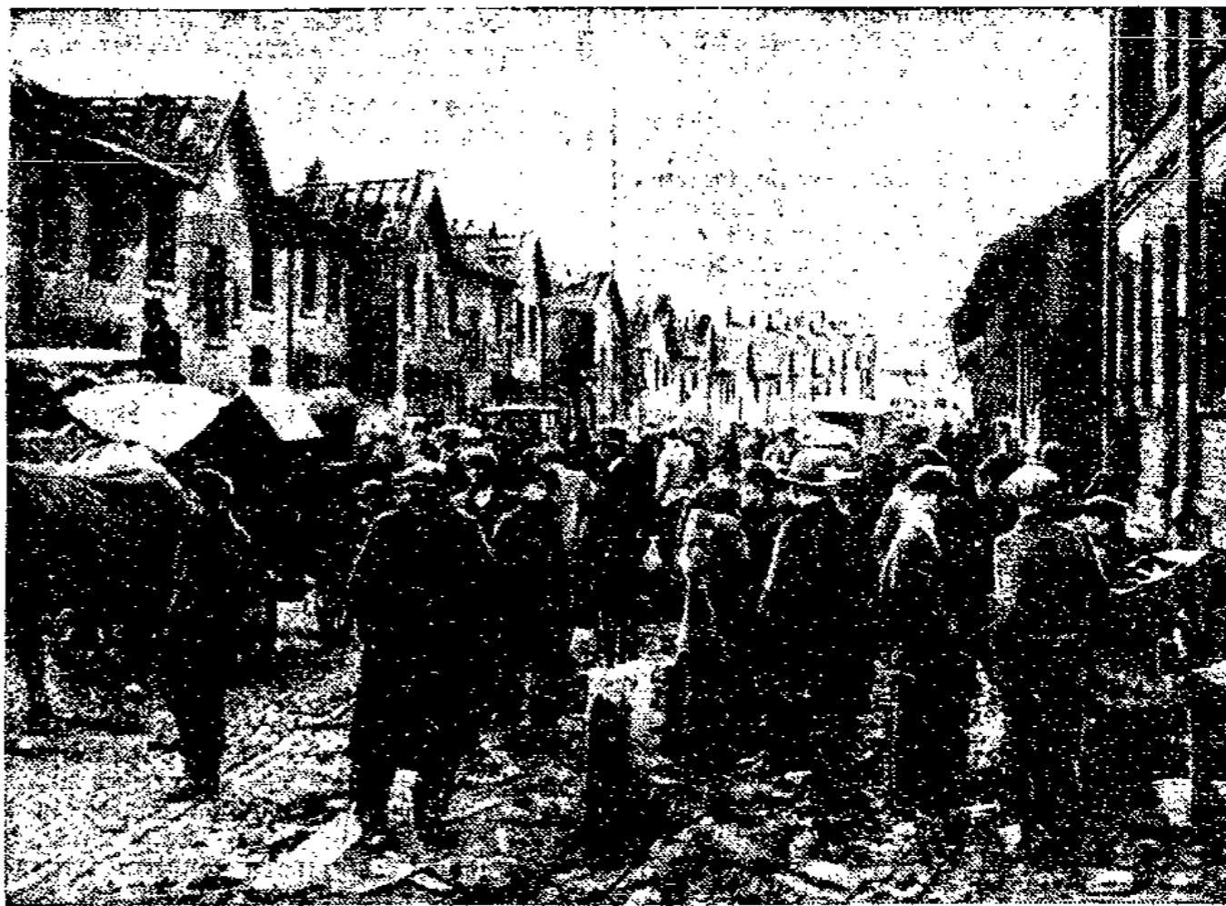
Eine Straße der Unglücksstadt Neunkirchen: durch den gewaltigen Luftdruck sind hier sämtliche Dächer abgedeckt worden.
