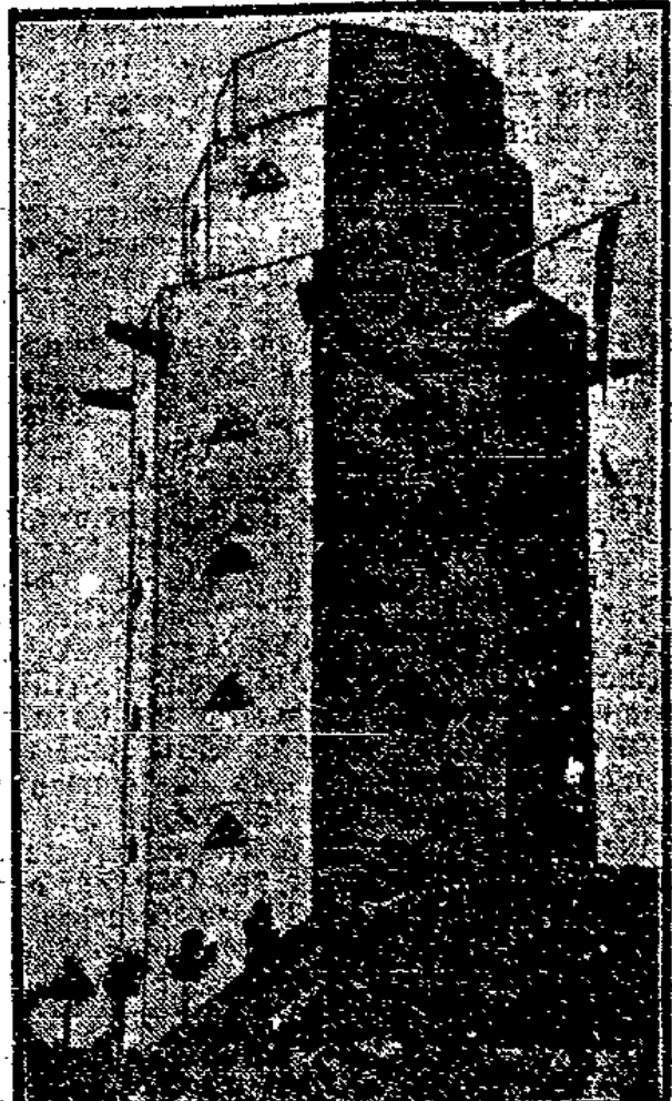
Der Wasserturm der Stadt Friedberg in Hesse ist zu einem Gefallenen-Ehrenmal umgestaltet worden, das in diesen Tagen eingeweiht wurde.
