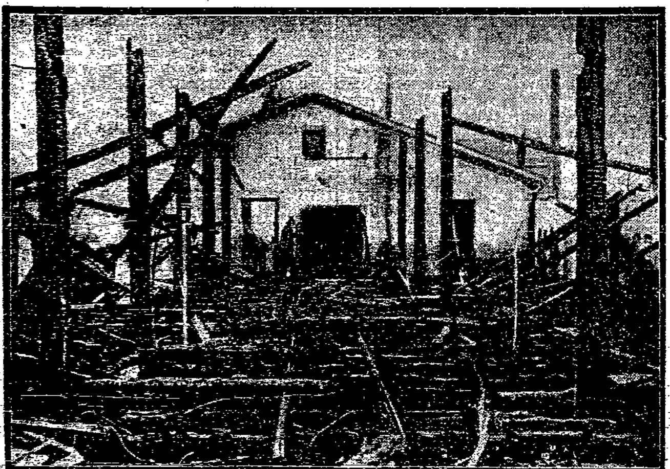
Auf dem Gelände der Deutschen Industriewerke in Spandau brach ein Großfeuer aus; das zu den größten Bränden zählt, von denen die Reichshauptstadt nach dem Kriege betroffen worden ist. Zwei
