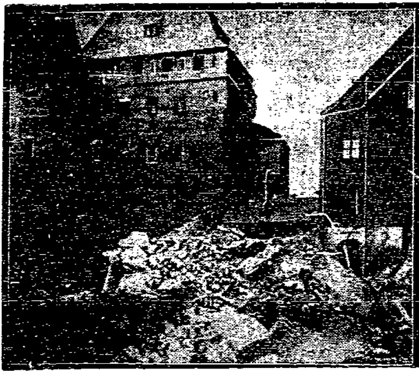
Der Römerturm in Neuß, hinter dem Obertor, ein historisches Baudenkmal, ist eingestürzt. Der Turm im Volksmund auch vielfach Hungerturm oder Mauerthurm bezeichnet, gehörte zu dem noch erhaltenebleibenden Teil der im 13. Jahrhundert erbauten Stadtbefestigung.
