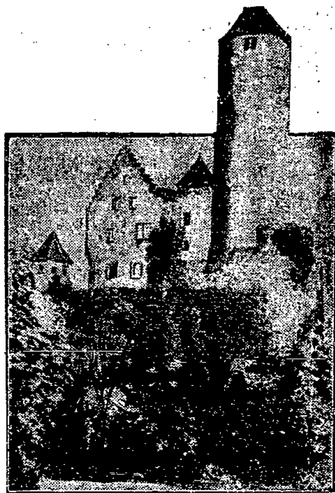
Die Burg Göz von Berlichingens mit der Ethernen Hand, Burg Hornberg a. N., wurde kürzlich durch Blitzschlag schwer beschädigt, so daß bis auf weiteres das Gebäude abgesperrt werden mußte, da Einsturzgefahr besteht.
