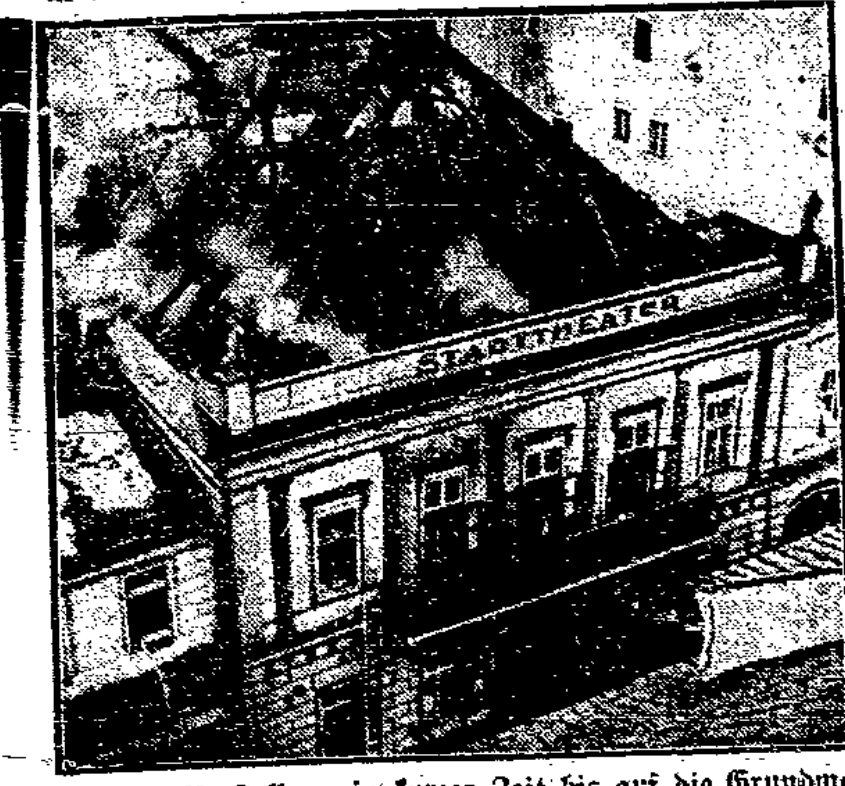
Das nach der Vorstellung in kurzer Zeit bis auf die Grundmauern ausbrannte.
