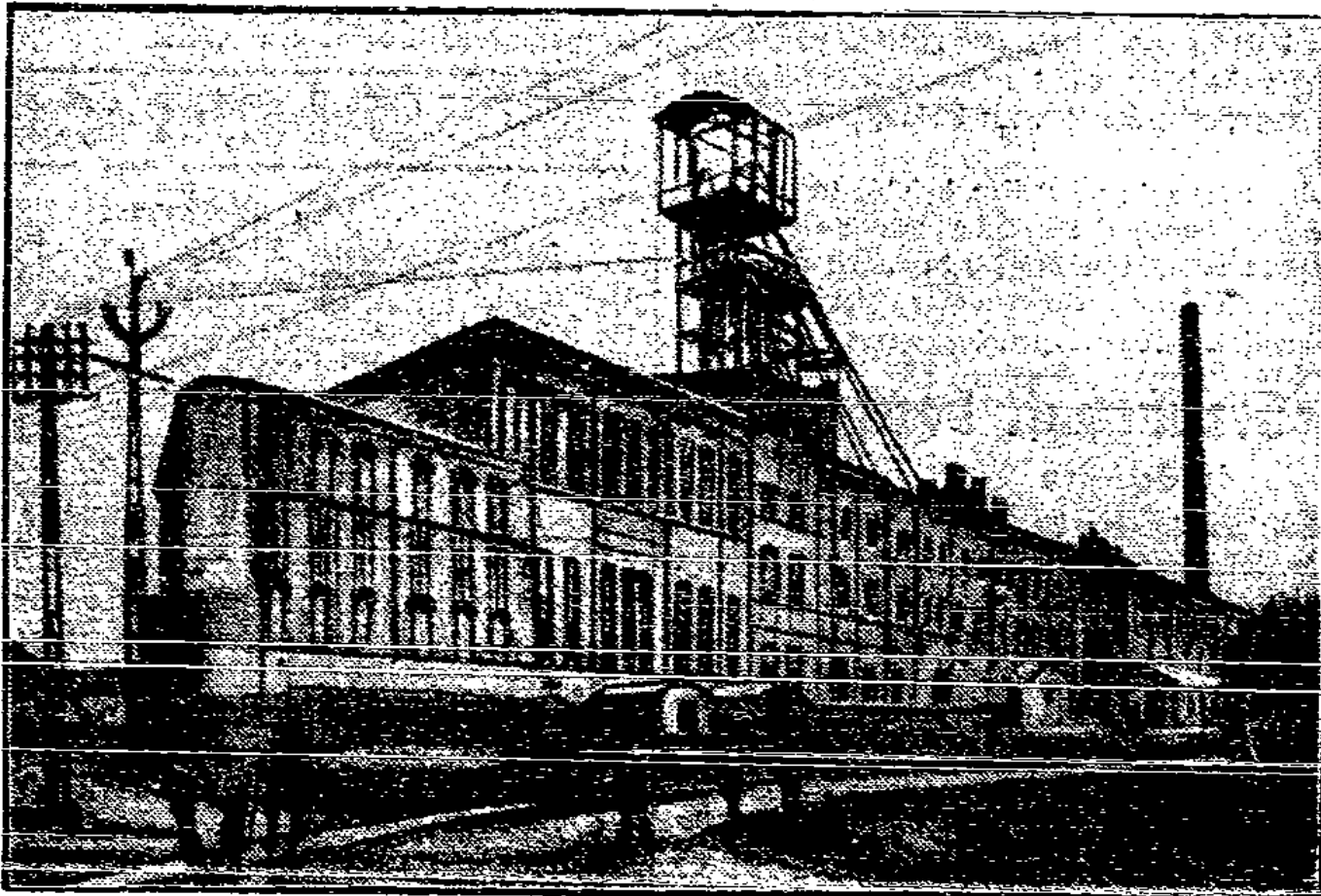
Der Schauplatz des Unglücks: der Wilhelm-Schacht der Grube Anna II
