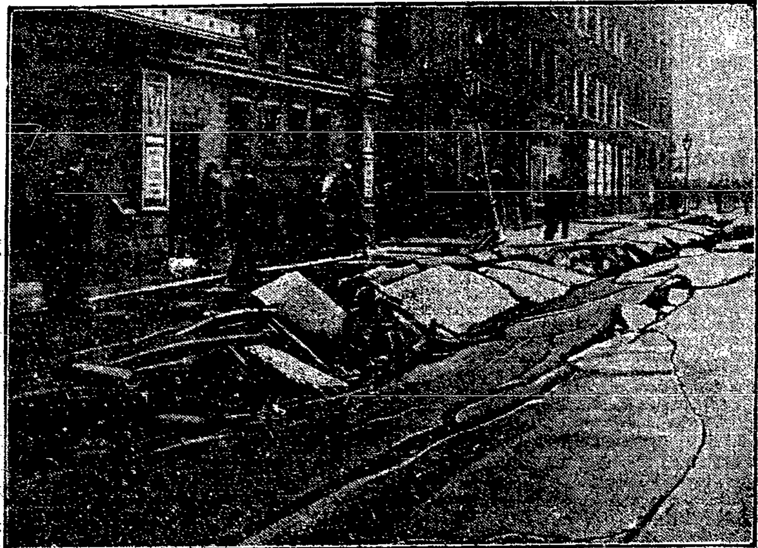
Ein Bild von der Zerstörung, die durch die Explosion unterirdischer Gasleitungen im Geschäftsviertel von London an-gerichtet wurde. Die jungen Straßenkinder wurden von Plünderern ergriffen und plündernd durch die Straßen getrieben.
