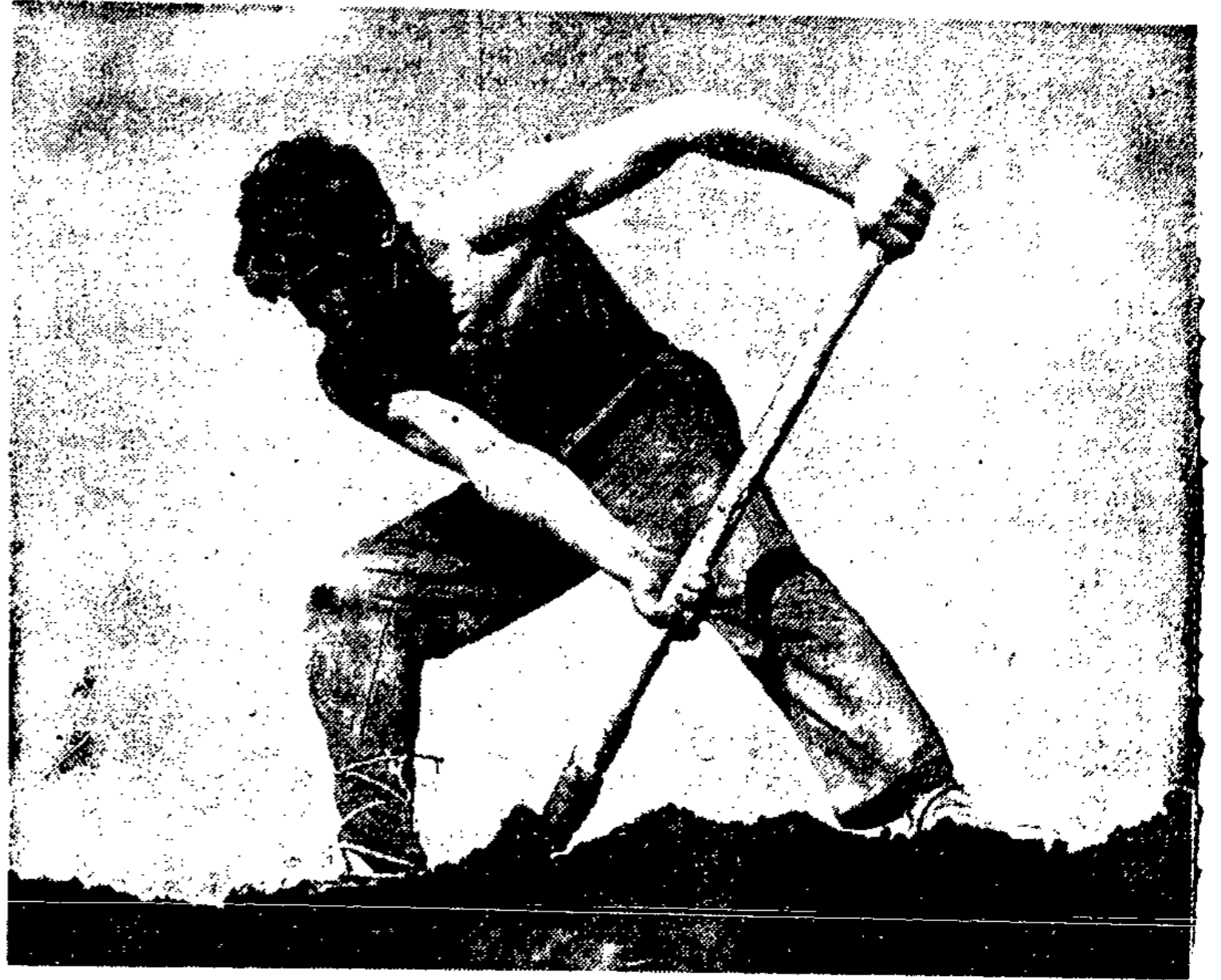
Der erste Spatenstich
