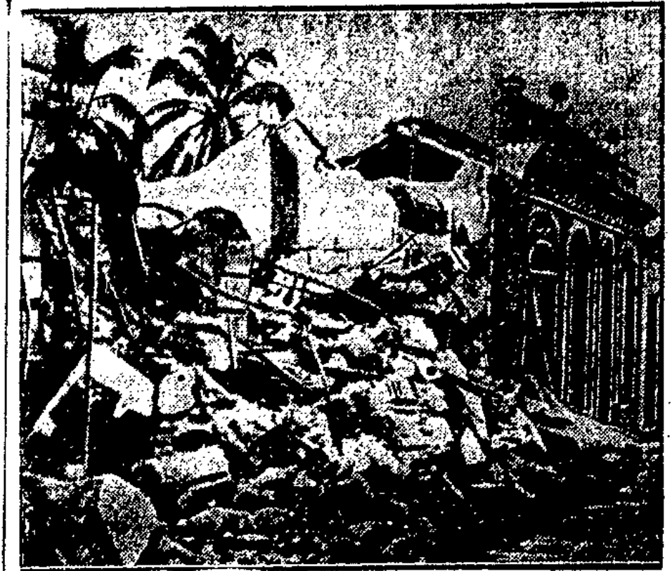
Santiago nach dem Erdbeben
