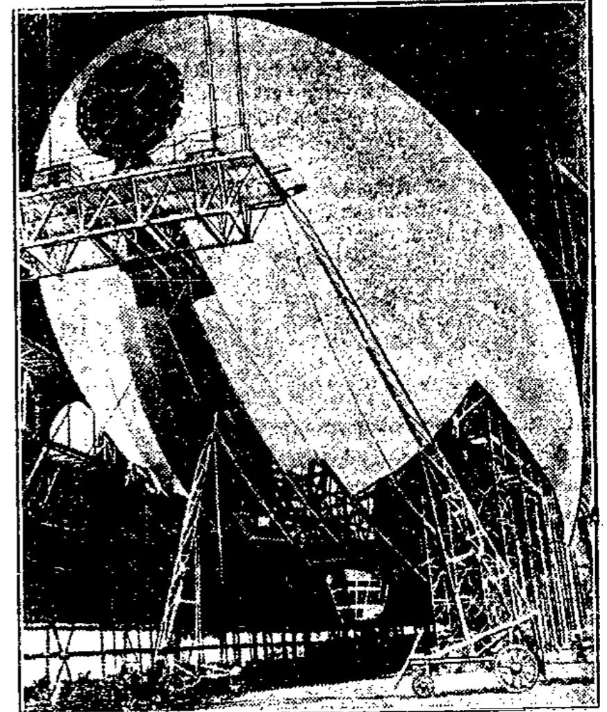
In Akron (Ohio) wird jetzt das größte Luftschiff der Welt, der Marschflugkreuzer „Akron“ fertiggestellt, er soll in allernächster Zeit seine ersten Probeflüge unternehmen. Eigens für dieses Luftschiff hat man einen neuartigen beweglichen Ankermast gebaut, der 25 Meter hoch ist und 130 Tonnen wiegt.
