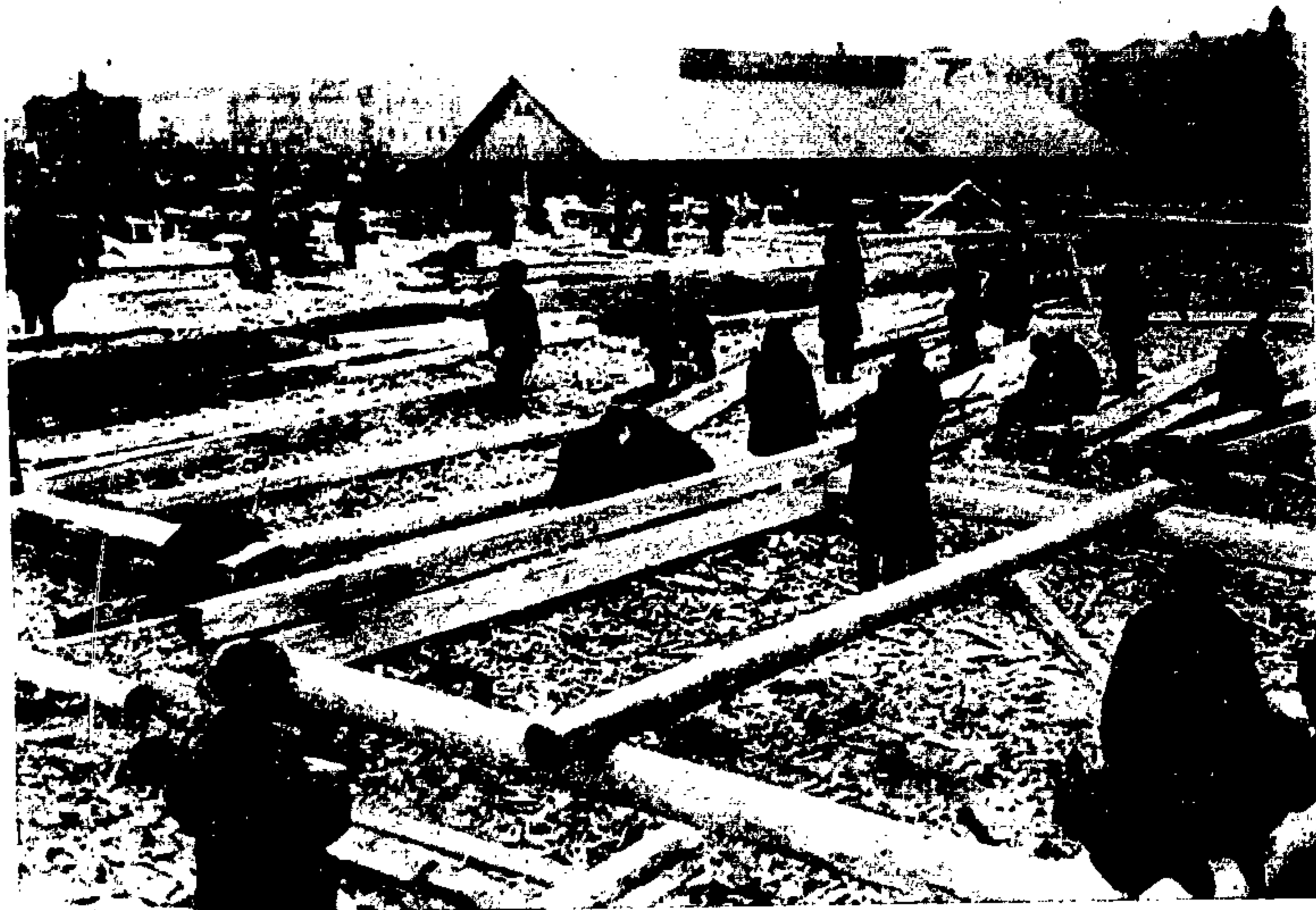
Übungsplatz, auf dem ungelerte Bauarbeiter als Zimmerer ausgebildet werden
