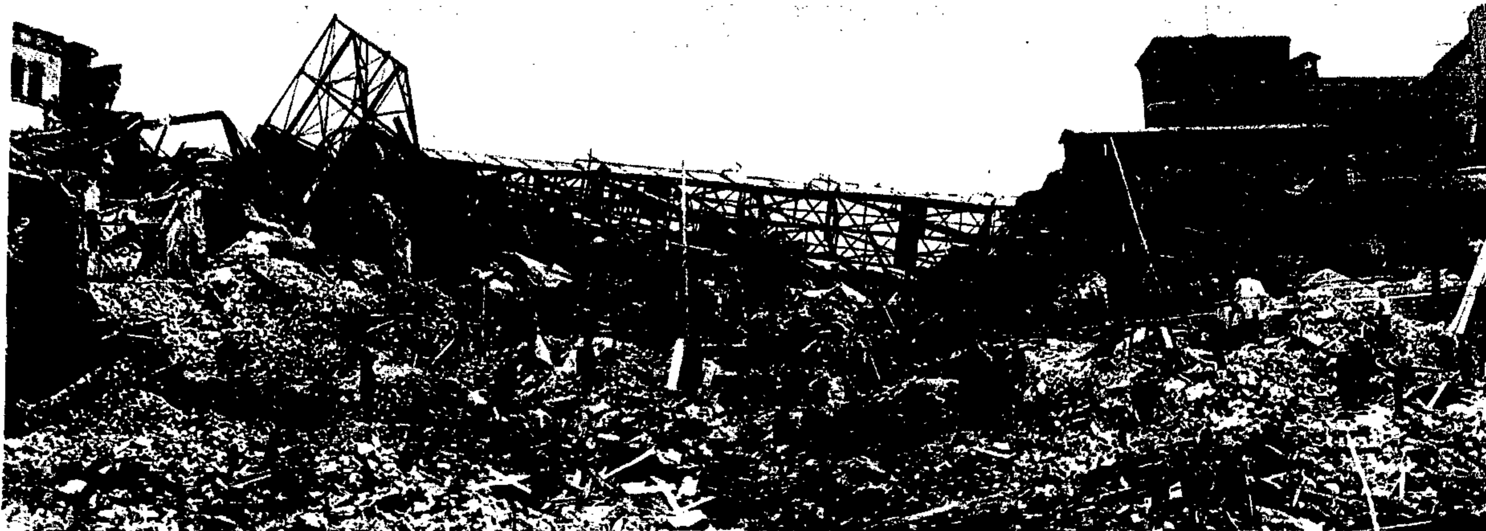
Das zerstörte Verwaltungsgebäude mit dem umgestürzten Förderturm des Schachtes „Anna II“
