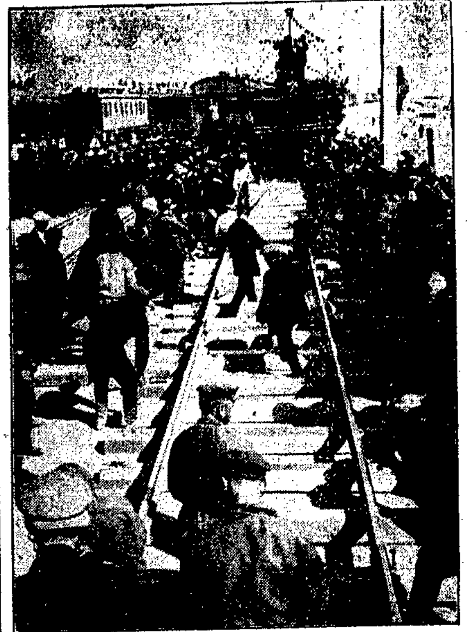
Unser Bild zeigt die Vereinigung der beiden Schienenstränge. Die Arbeiter befestigen die letzten Schrauben. Einige Minuten später fährt unter brausendem Jubel aller von nah und fern herbeigeeilten Zuschauer der erste Eisenbahnzug über die vereinigten Strecken.
