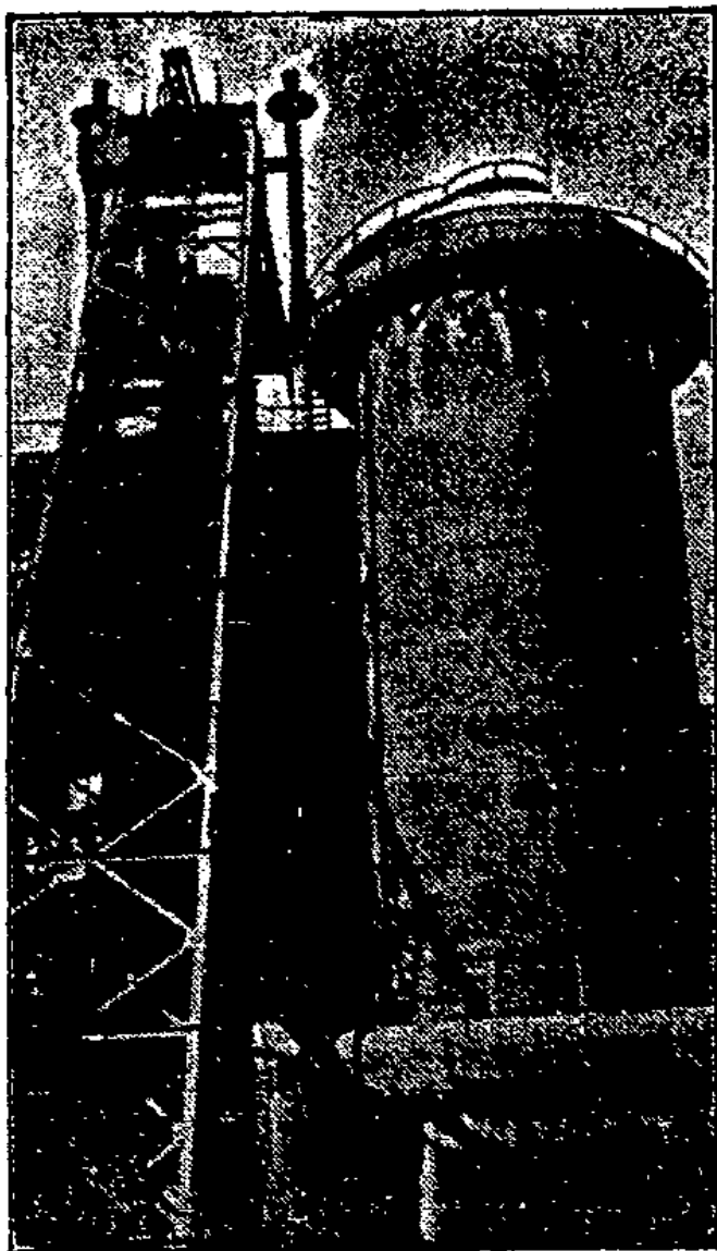
Neue Hochvoltsanlage im Donezrevier
