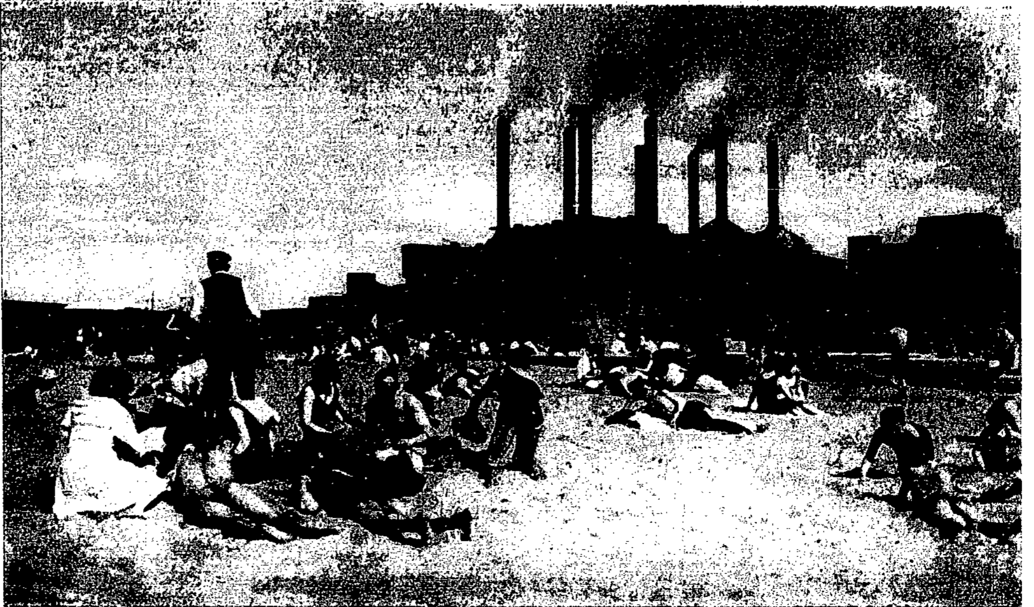
Badeanstalt Lichtenberg, im Hintergrund das gigantische Kraftwerk Klingenberg
