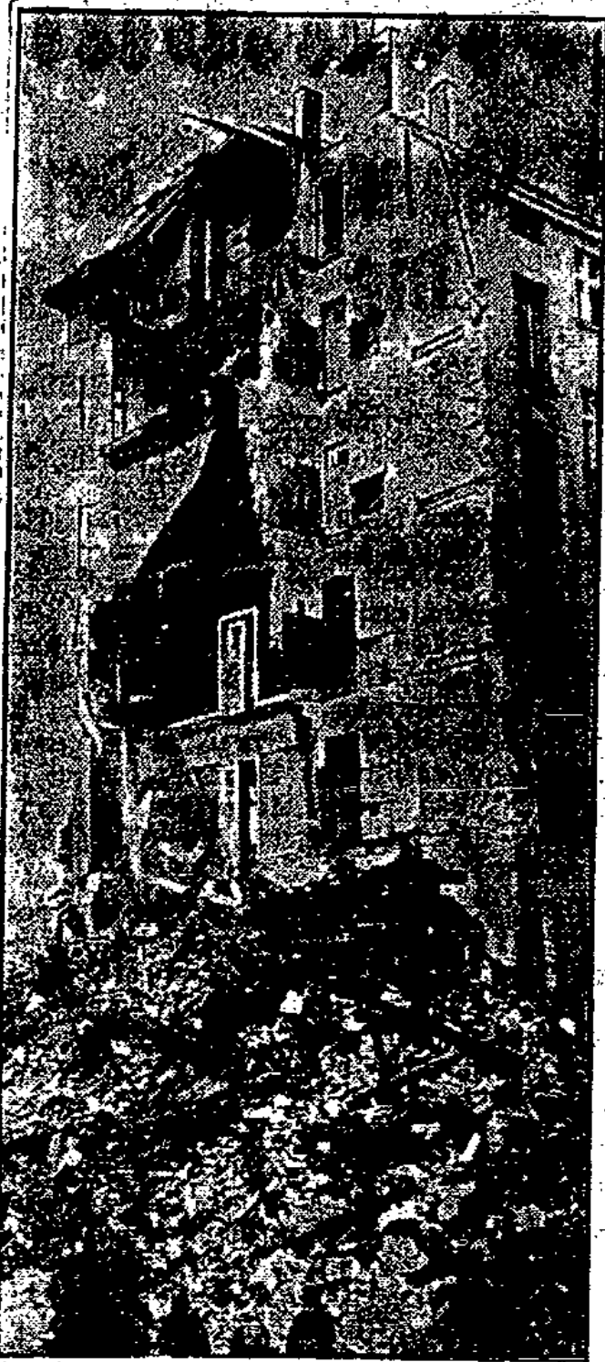
Das eingestürzte Haus.
